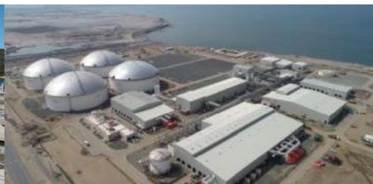
Desaladora y sistemas de distribución en Jizán, Arabia Saudí
