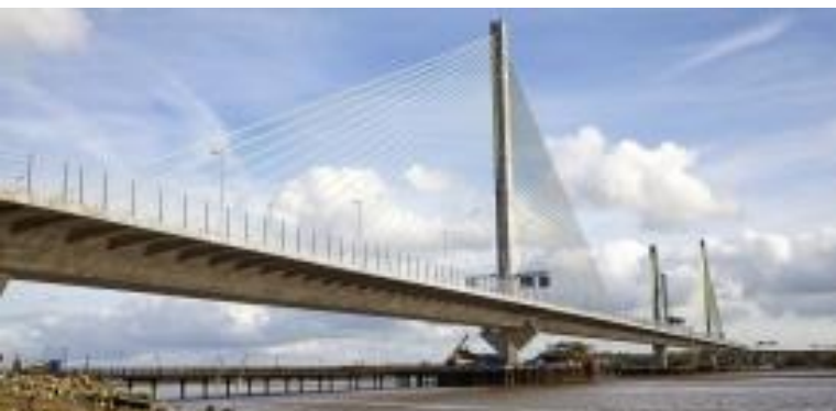
Puente Mersey en Liverpool, Reino Unido
