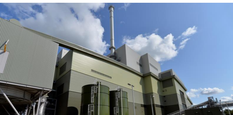
Planta de reciclaje y valorización energética de residuos en Millerhill, Edimburgo
