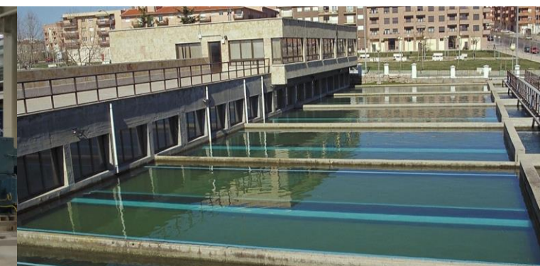
Estación de tratamiento de agua potable en Salamanca, España
