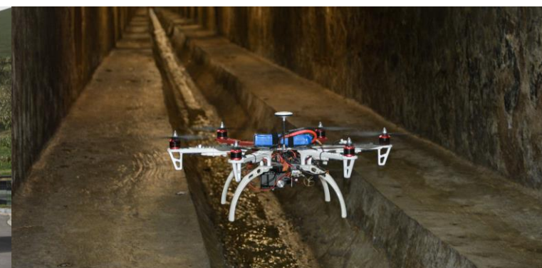
Dron para la inspección de alcantarillado en Barcelona, España
