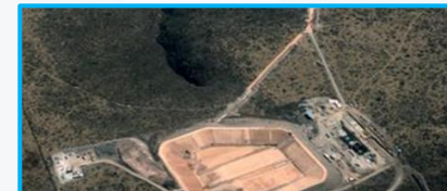
Diseño, Construcción y Financiación de Infraestructuras hidráulicas
