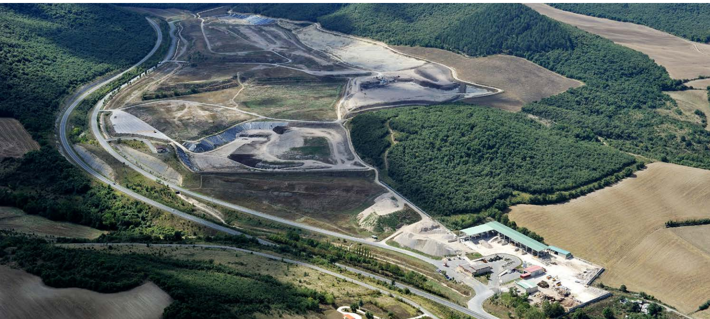
El vertedero de residuos sólidos de Gardélegui (Vitoria, Álava).
