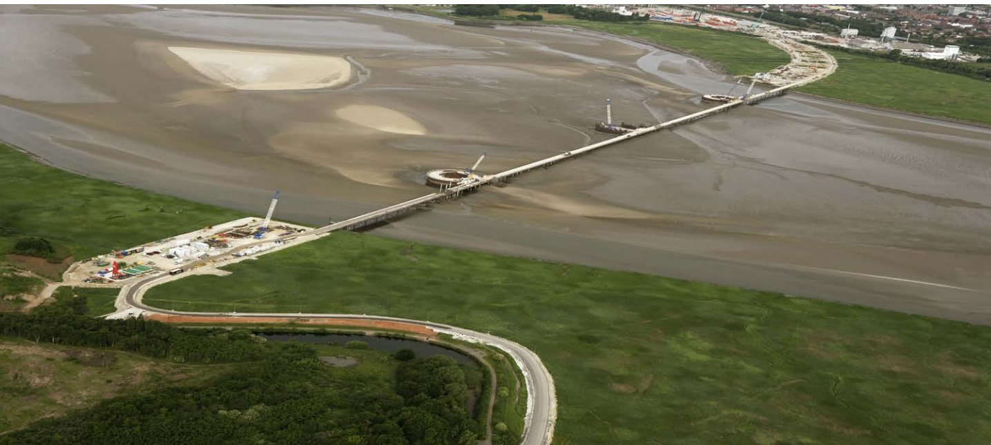
Viaducto de Mersey (Reino Unido).
