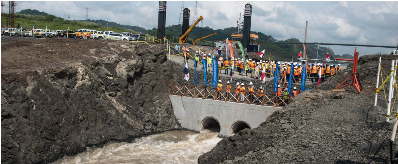
Pruebas de llenado del PAC 4 de la ampliación del Canal de Panamá (Panamá).
