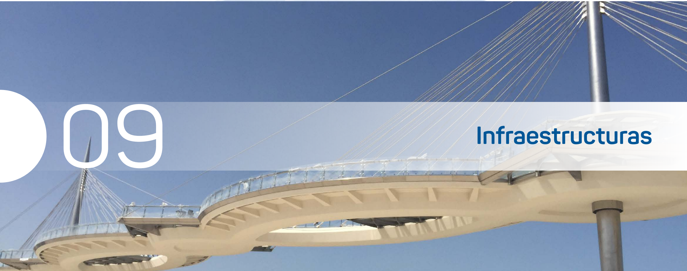
Pasarelas de Lusail (Qatar).
