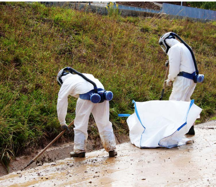
Trabajos de descontaminación de suelos en Bailín, Huesca (España).
