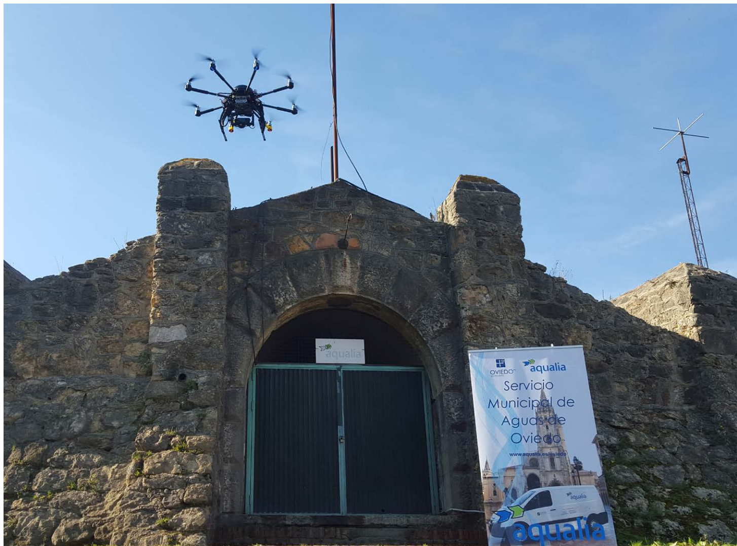
Actuación de un dron en el depósito de Picayón, Oviedo (España).
