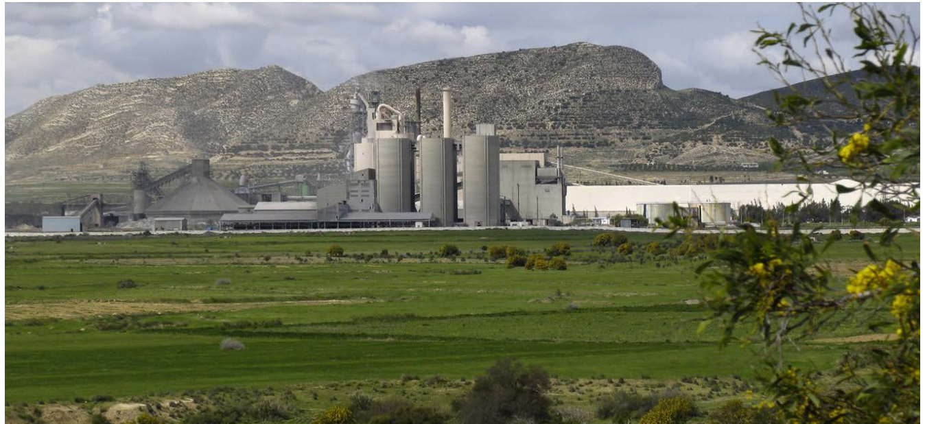
Fábrica de Société des Ciments d'Enfidha (Túnez).
