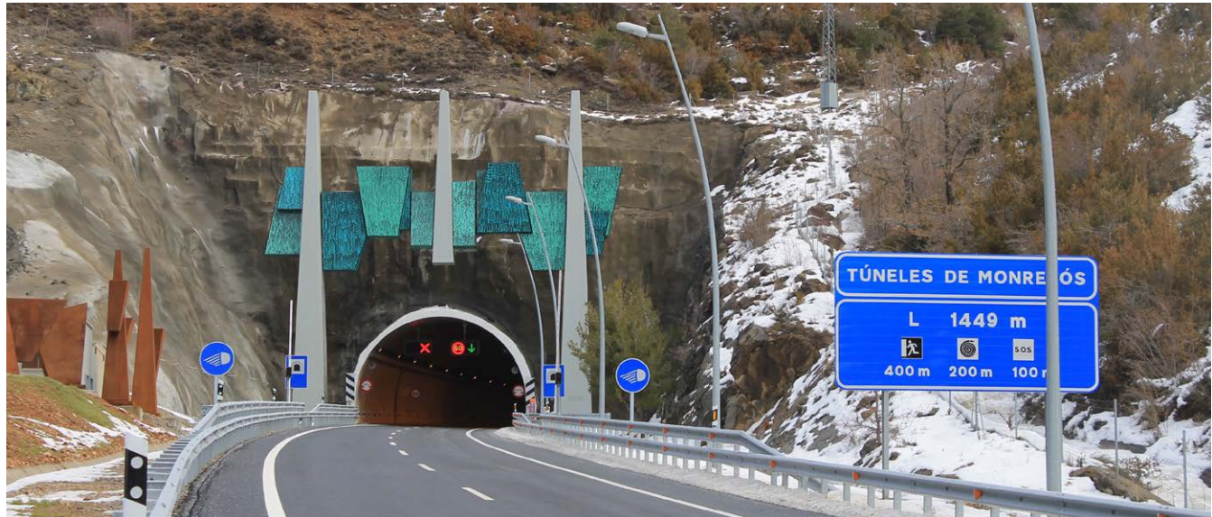
Integración de Sistemas de Control de túneles carreteros. Monrepós, Huesca (España).
