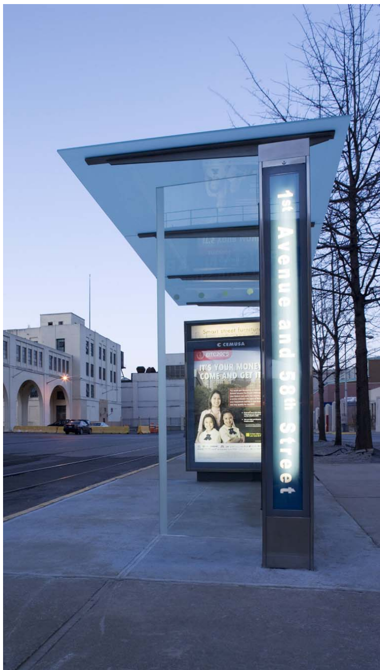
Marquesina de autobús de Nueva York
