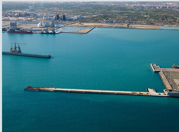
Dique este puerto de Castellón
