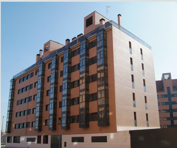
Viviendas área norte, Las Tablas (Madrid)
