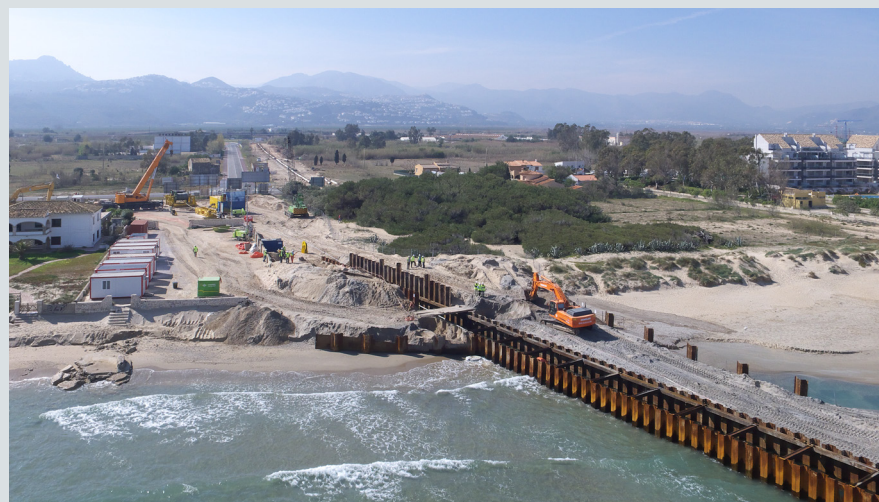
Denia Landfall 3. Gasoducto submarino
