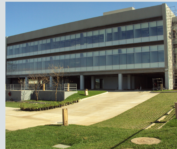
Edificio oficinas BID Nicaragua
