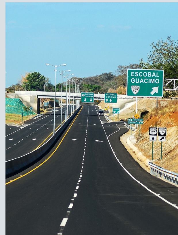
Autopista San José Caldera (Costa Rica)
