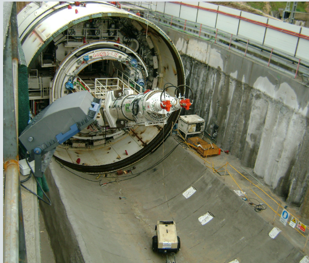
Tuneladora túnel Ave-Atocha-Chamartín (Madrid)
