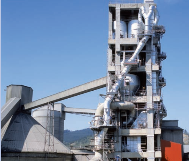
Fábrica de Cementos Lemona. Vizcaya
