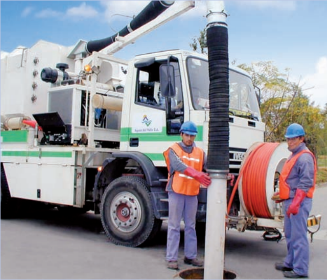
Limpieza de alcantarillado. Aguas del Valle. Argentina
