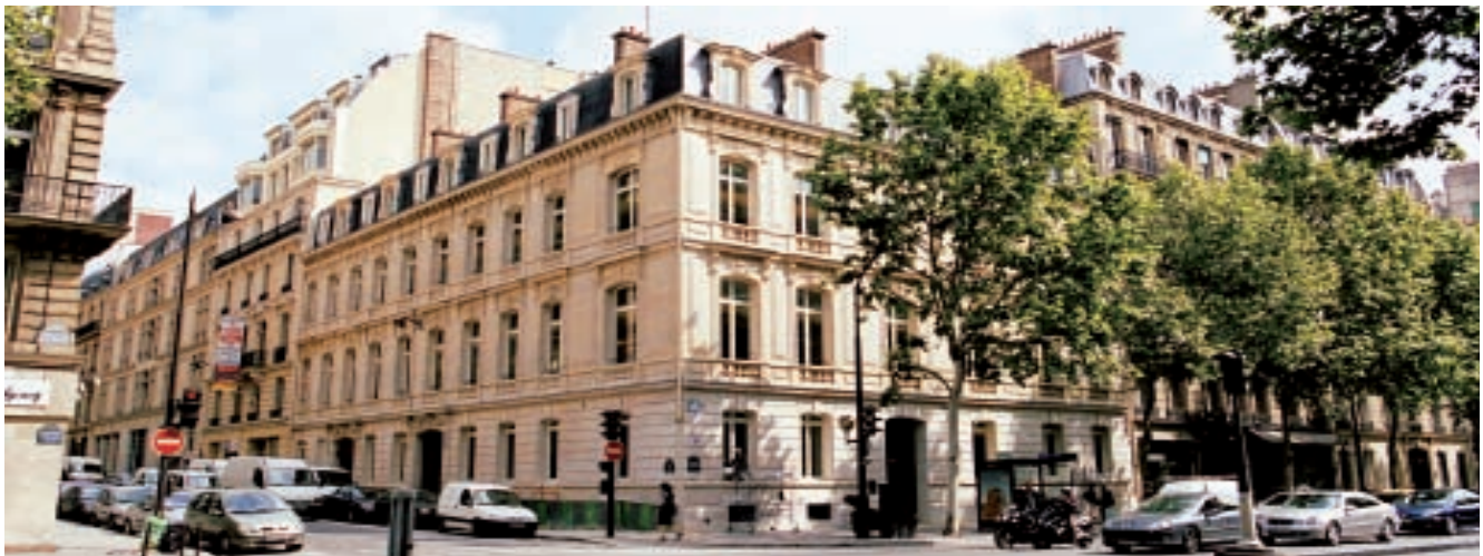
Edificio en el boulevard Haussman. París
