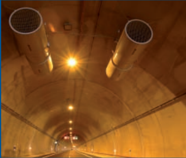
Túnel Sierra del Aguilón. Autopista Cartagena-Vera
