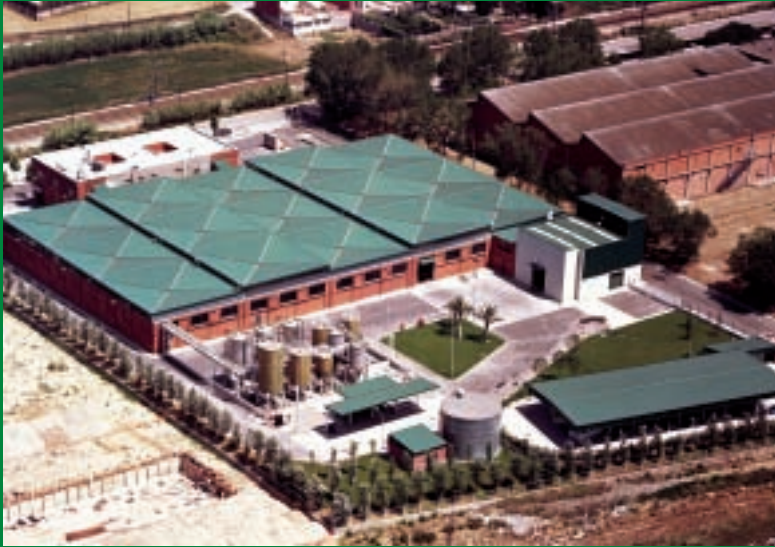
Planta de transferencia de Montmeló. Barcelona
