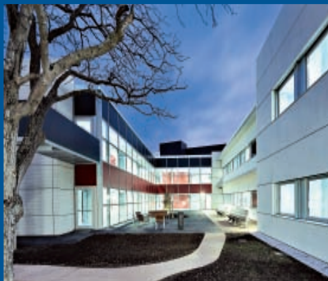
Centro de disminuidos psíquicos San José. Pamplona
