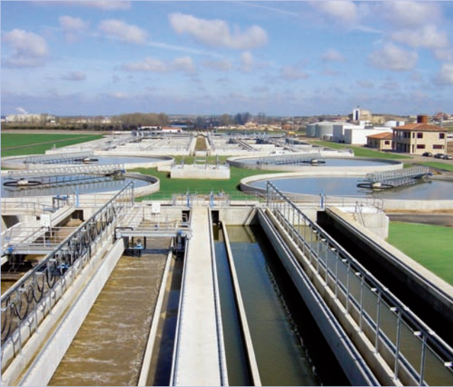
Estación depuradora de aguas residuales. Salamanca
