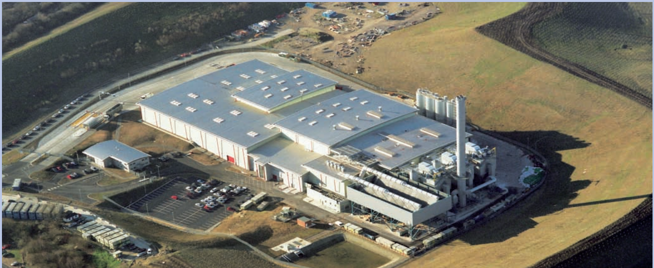
Planta de tratamiento térmico de residuos. Alington. Reino Unido
