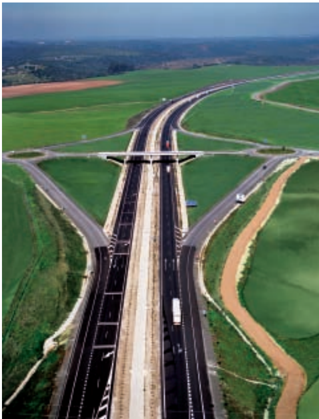
Autovía de La Plata. Tramo Gerena-Camas. Sevilla
