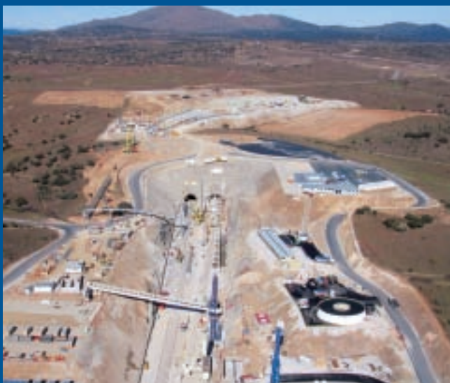
Túneles de San Pedro. Madrid
