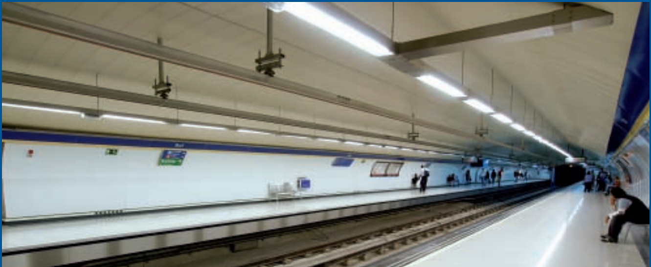
Ampliación de andenes en la estación Sol de la línea 3. Madrid
