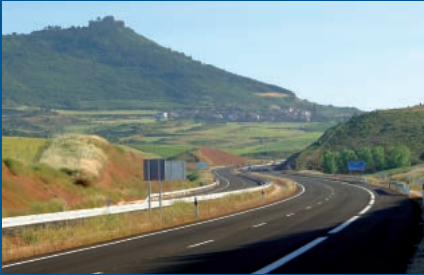
Autovía del Camino. Tramo Pamplona-Logroño
