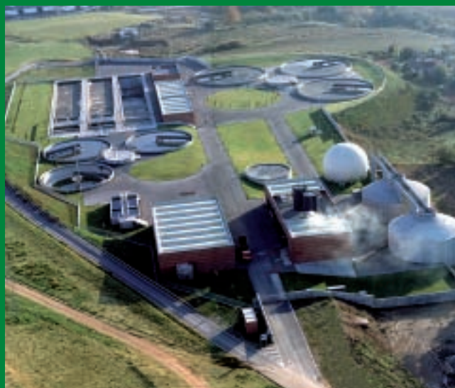
Depuradora de Sabadell (SPA). Barcelona
